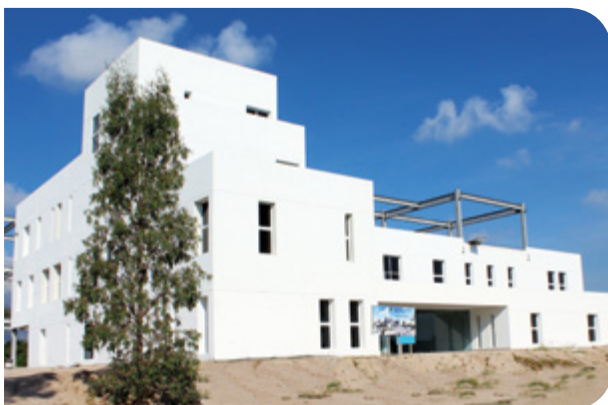
Tercera etapa de construcción del edificio de la Fiscalía General del Estado.
