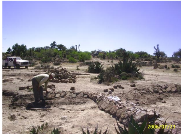
Cabeceo para proteger el suelo de erosión.
