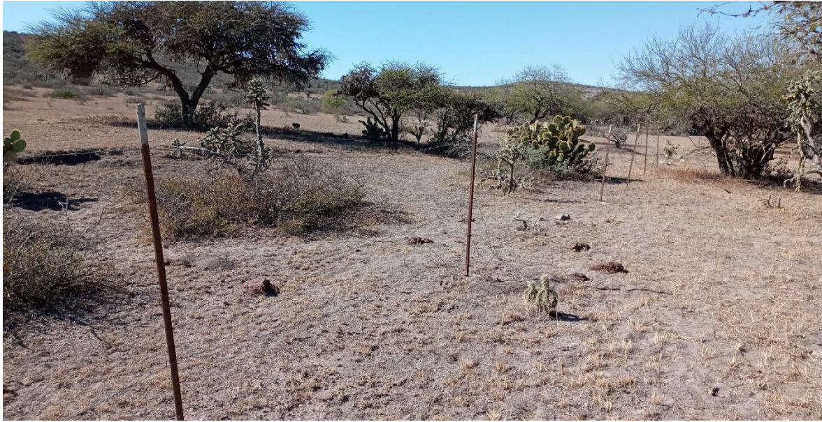
Figura 14. Daño en la cerca perimetral al norte del cráter.
