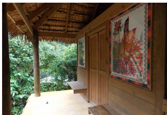
Foto 51. Caseta de cobro
