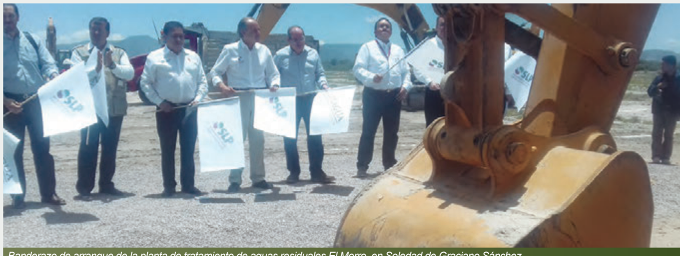
Banderazo de arranque de la planta de tratamiento de aguas residuales El Morro , en Soledad de Graciano Sánchez.
