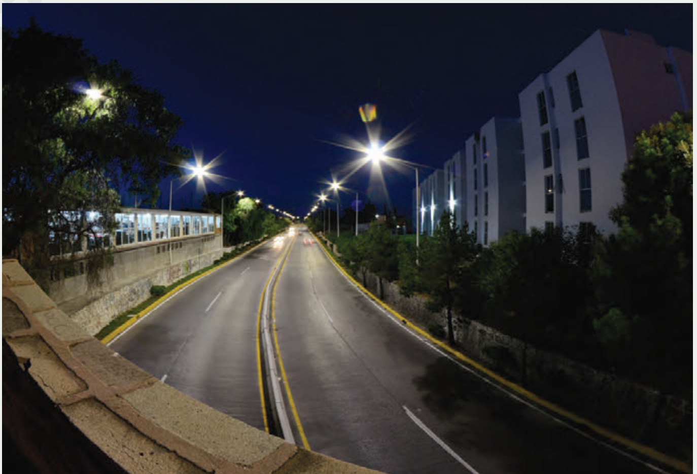
Iluminación LED en el bulevar Río Española.
